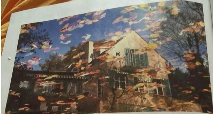
Το κτίριο Ερμιτάζ.
